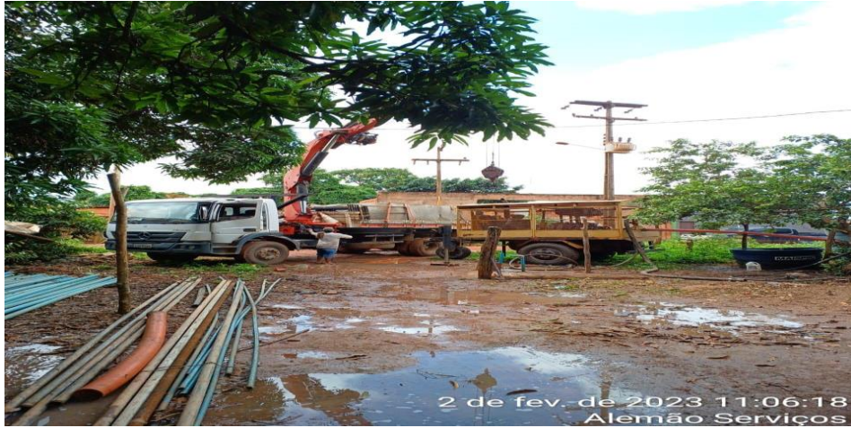
Técnicos realizando vistoria e manutenção em um dos poços
